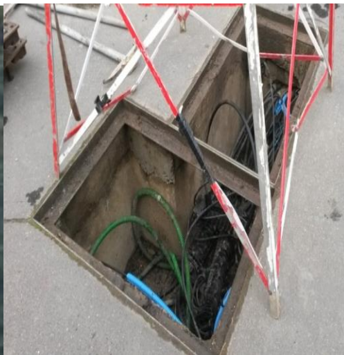
Tirage de câble Neuilly-en-Thelle - 12 02 2015
