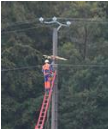
Déploiement câble sur support ERDF (Moyenne tension) Montreuil-sur- Thérain 24 07 2014
